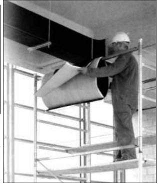
Непосредственно перед монтажом выдержать самоклеящийся материал в отапливаемом помещении при температуре не ниже 15°C в течение 24 часов. При этом рулон необходимо перемотать клеевой стороной внутрь намотки для снятия остаточной деформации. Минимальная температура окружающей среды при монтаже +5°C, температура монтажной поверхности не менее +5°C.
